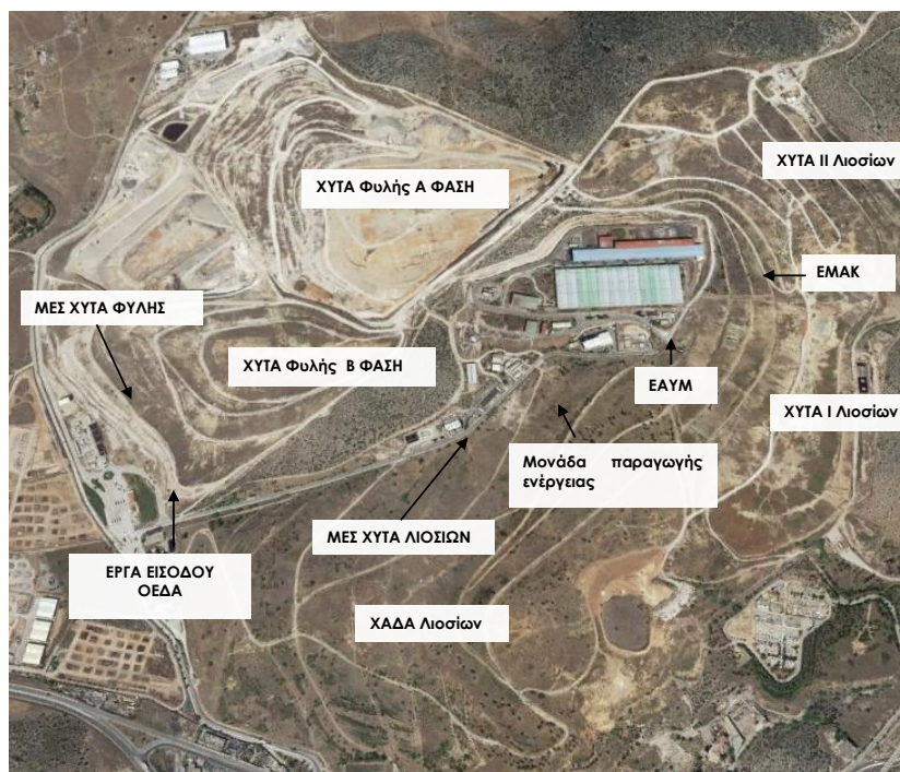
Εικόνα 3-1: Υποδομές ΟΕΔΑ Δυτικής Αττικής
