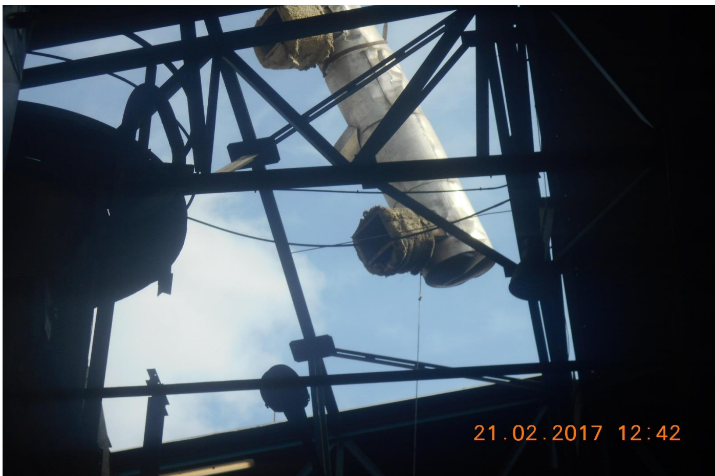
Φωτό 1097: Εργασίες συντήρησης στους εναλλάκτες θερμότητας
