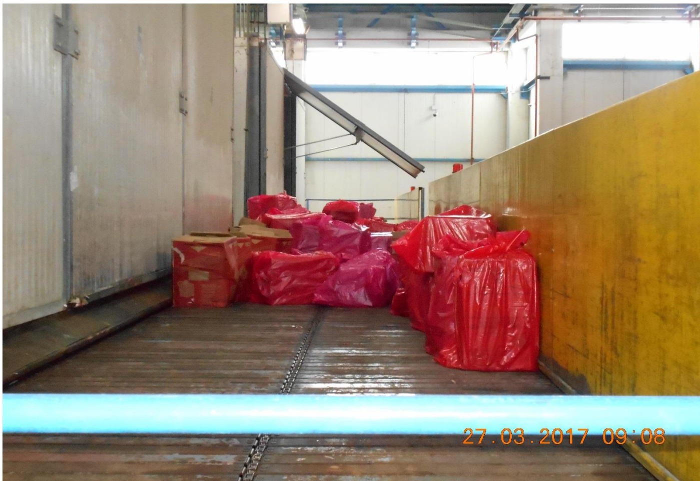
Φωτό 1304: Ταινιόδρομος ψυκτικών θαλάμων
