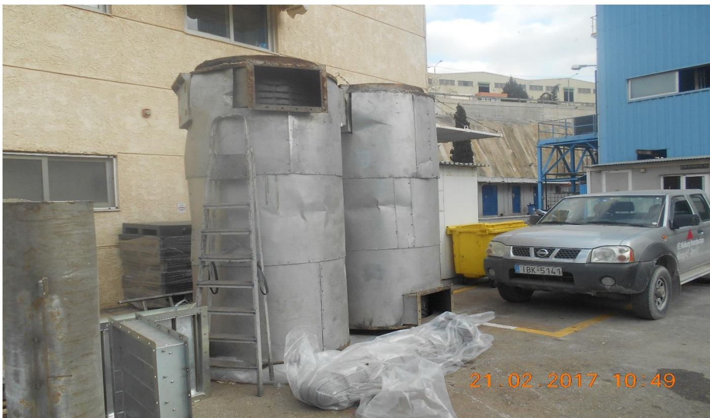
Φωτό 1075:Στοιχεία εναλλάκτη (αντικατάσταση)
