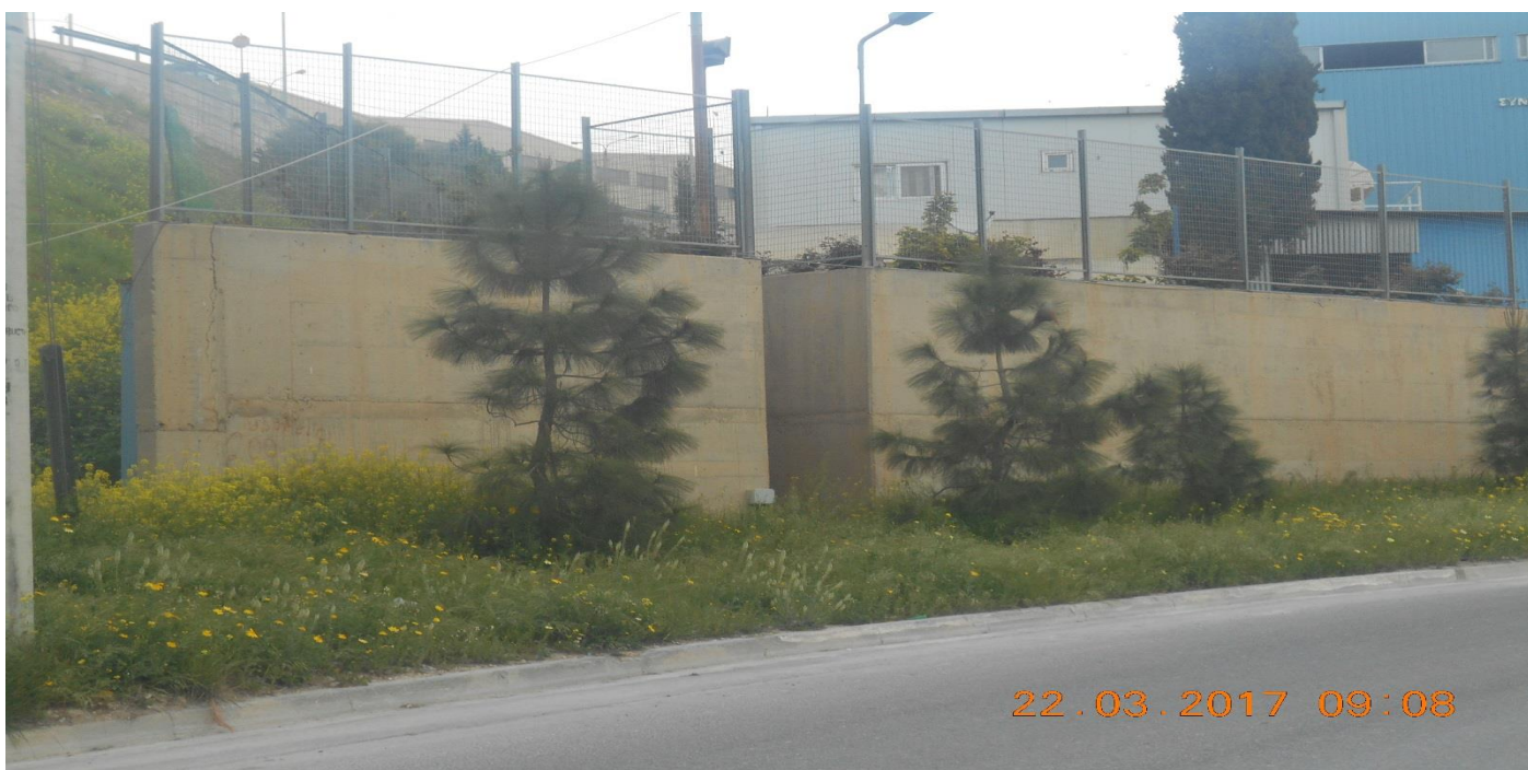
Φωτό 1212: Άποψη περιφραξης χώρου Μονάδας αποτέφρωσης
