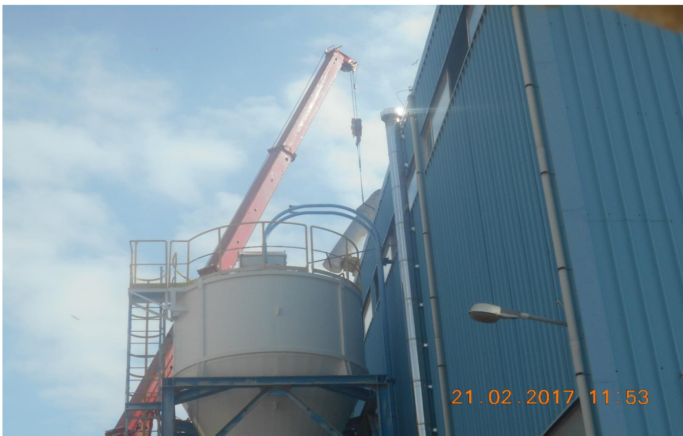
Φωτό1086 Εργασίες συντήρησης
