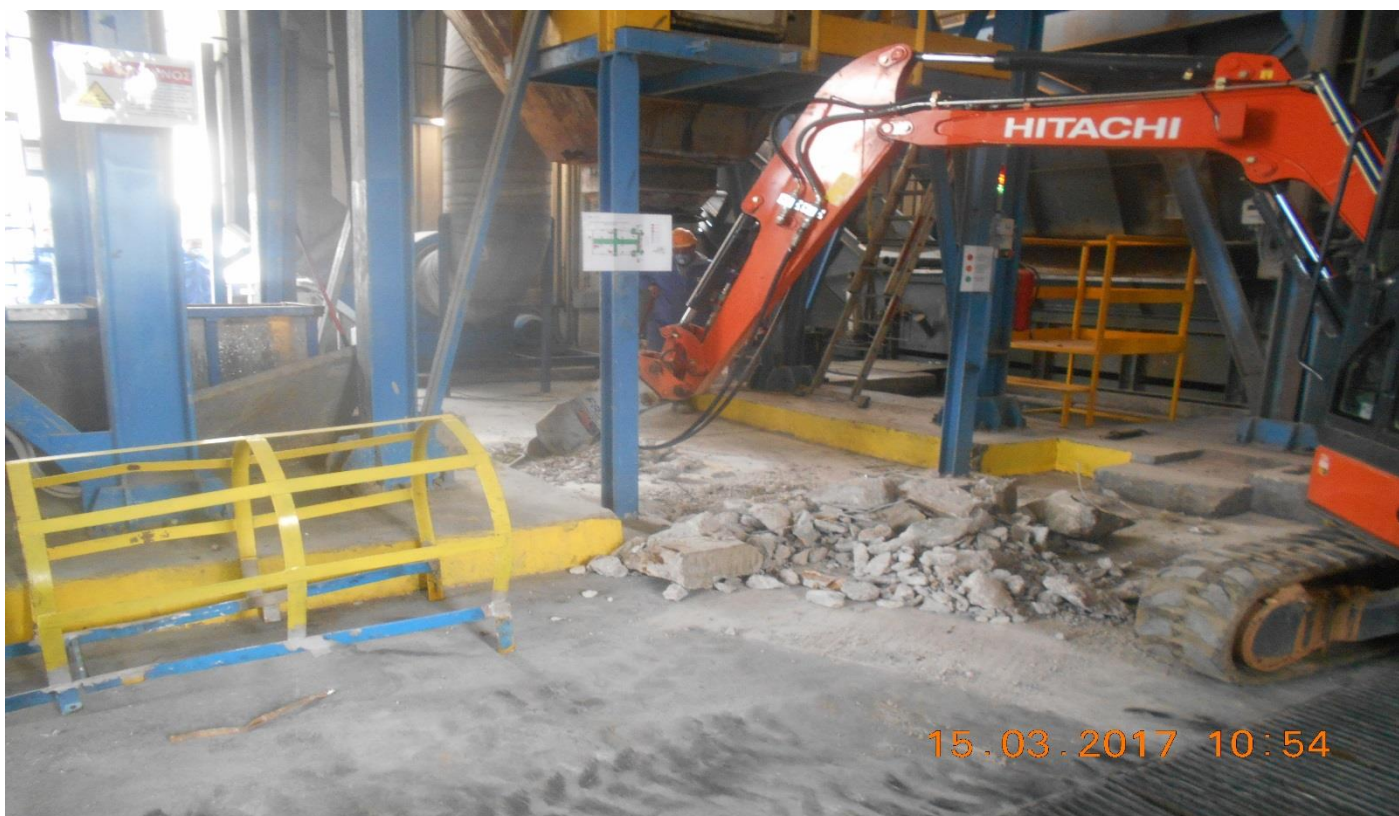
Φωτό 1188: Εργασίες για την τοποθέτηση νέου εξολκέα τέφρας στον εναλλάκτη θερμότητας
