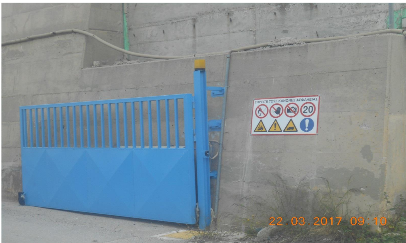
Φωτό 1214: Σήμανση ασφαλείας στην είσοδο της εγκατάστασης
