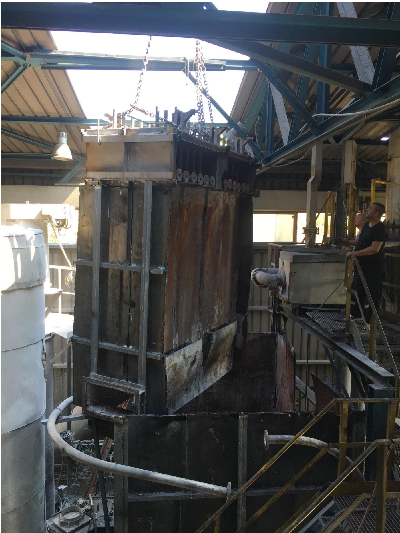
Φωτό 1582: Εργασίες εξαγωγής σακκόφιλτρου
