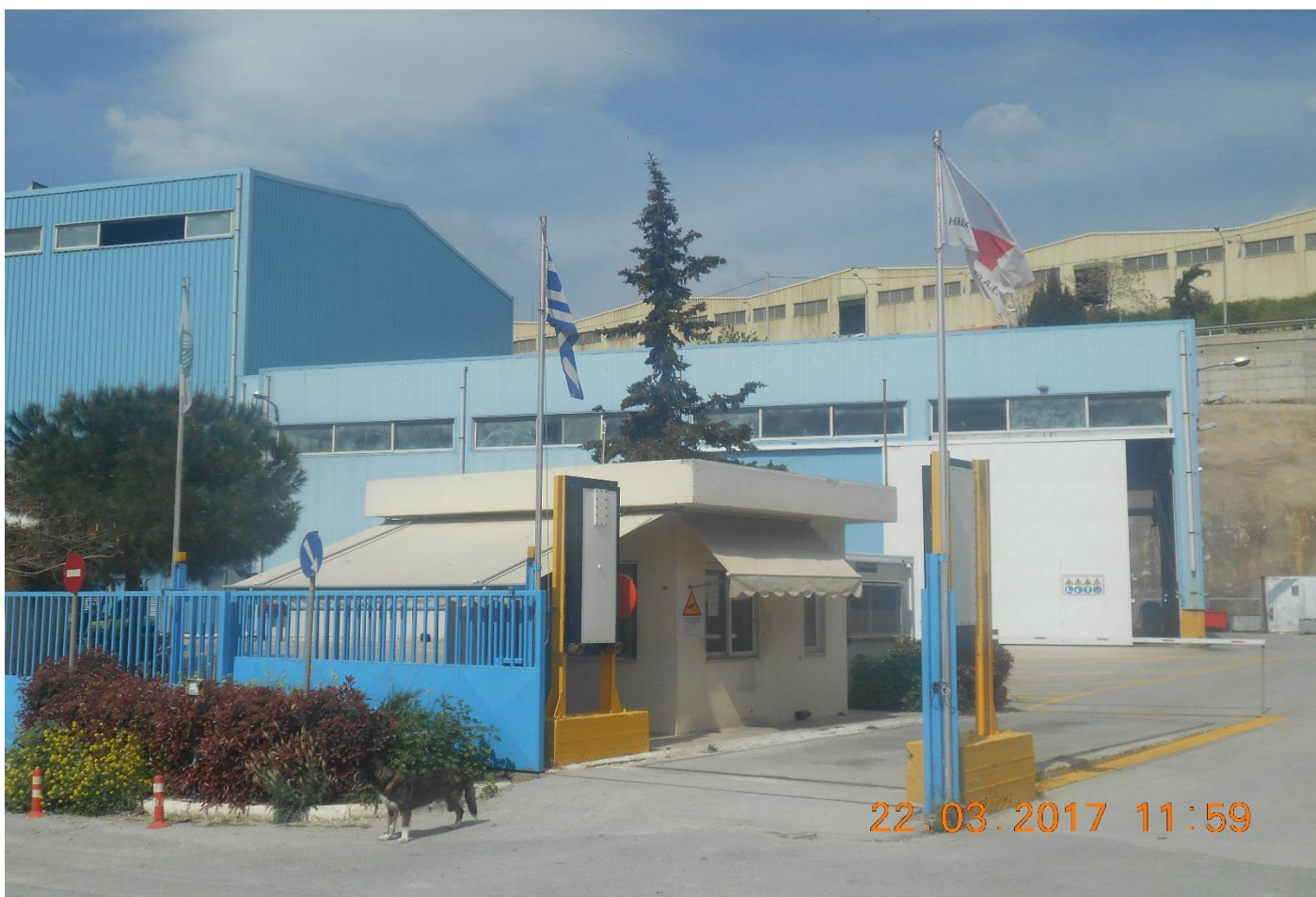
Φωτό 1277: Σταθερή διάταξη ανίχνευσης ραδιενεργών υλικών και πύλη εισόδου
