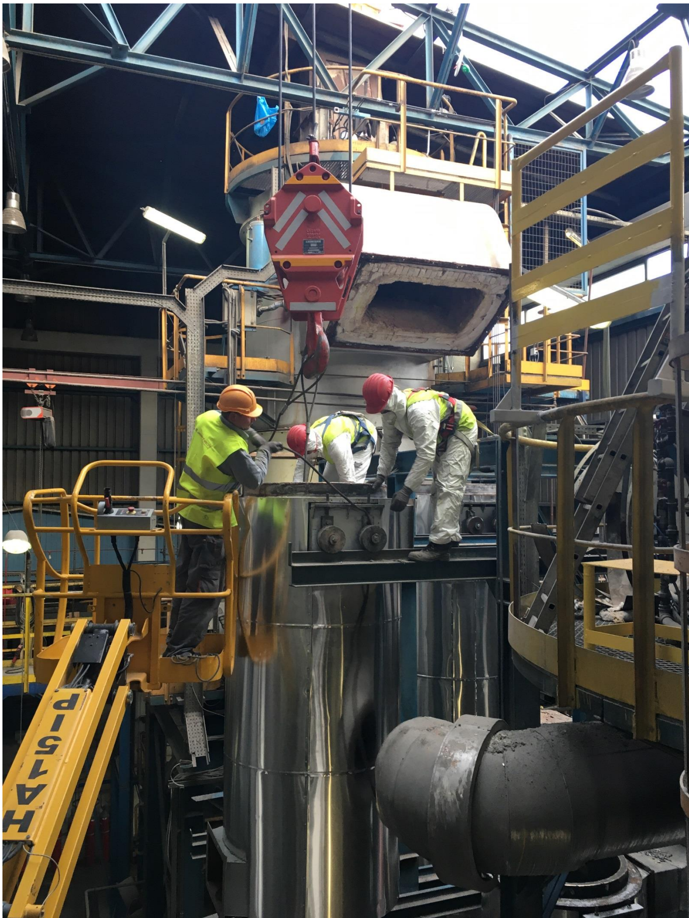
Φωτό 3766: Τοποθέτηση στοιχείων εναλλάκτη
