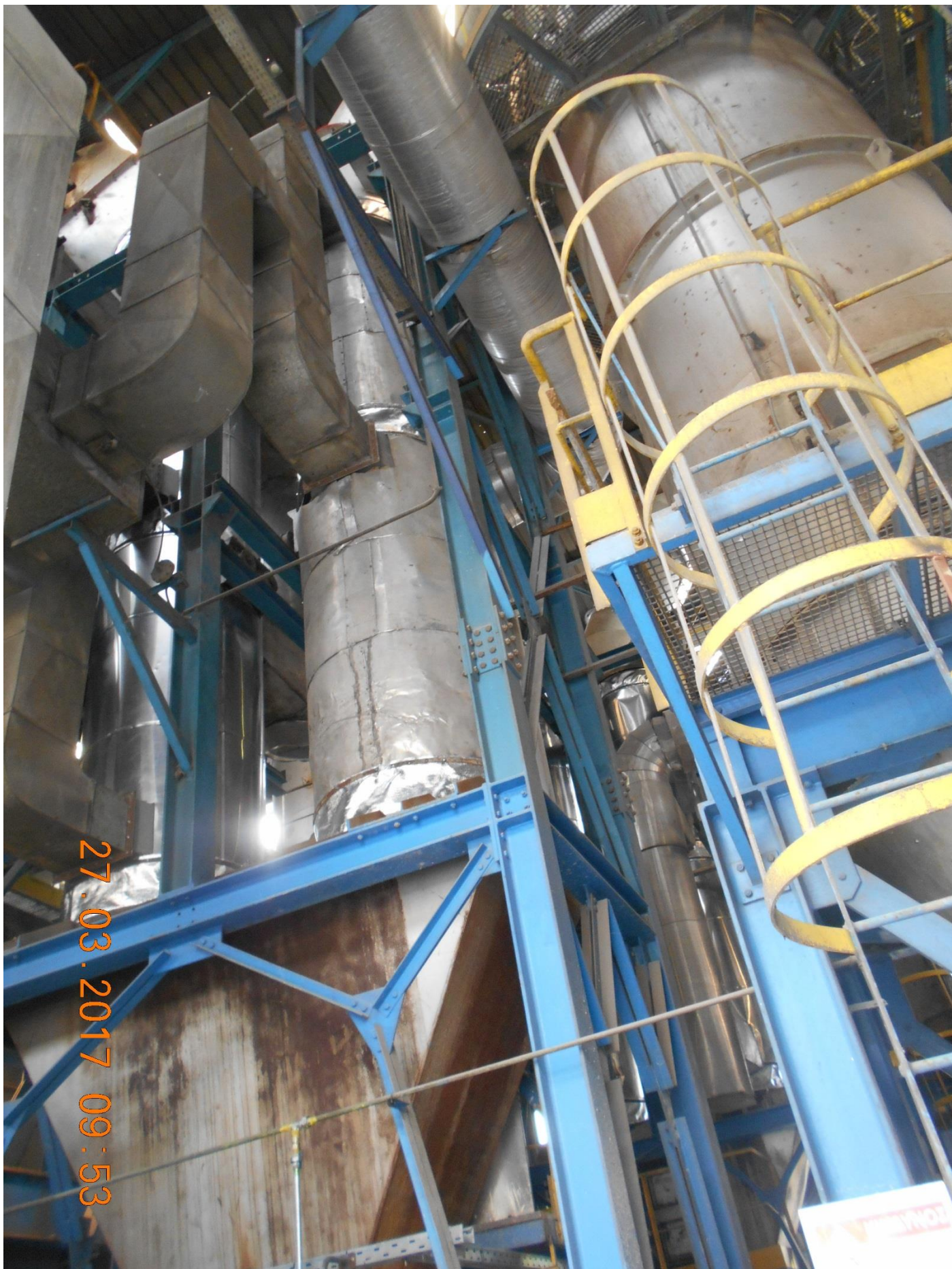
Φωτό 1315: Στοιχεία εναλλάκτη θερμότητας
