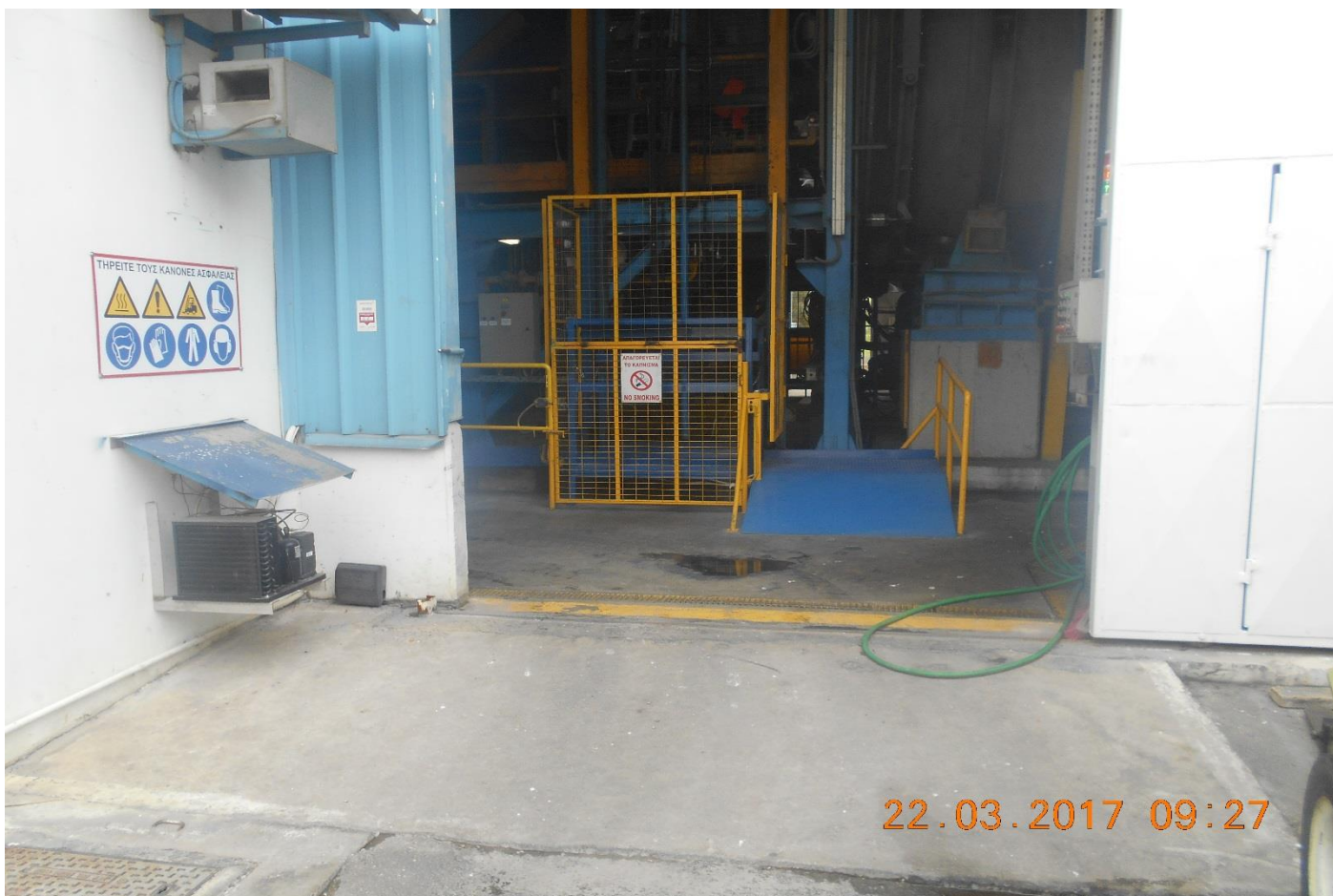
Φωτό 1247: Αναβατήριο φόρτωσης
