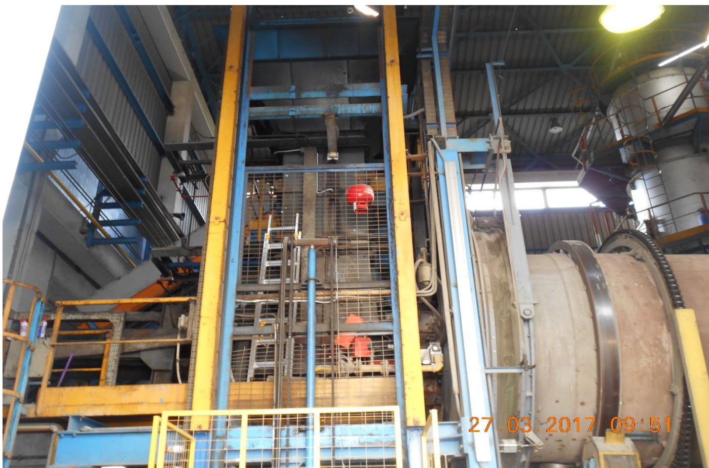
Φωτό 1310: Πυροσβεστικό μέσο οροφής
