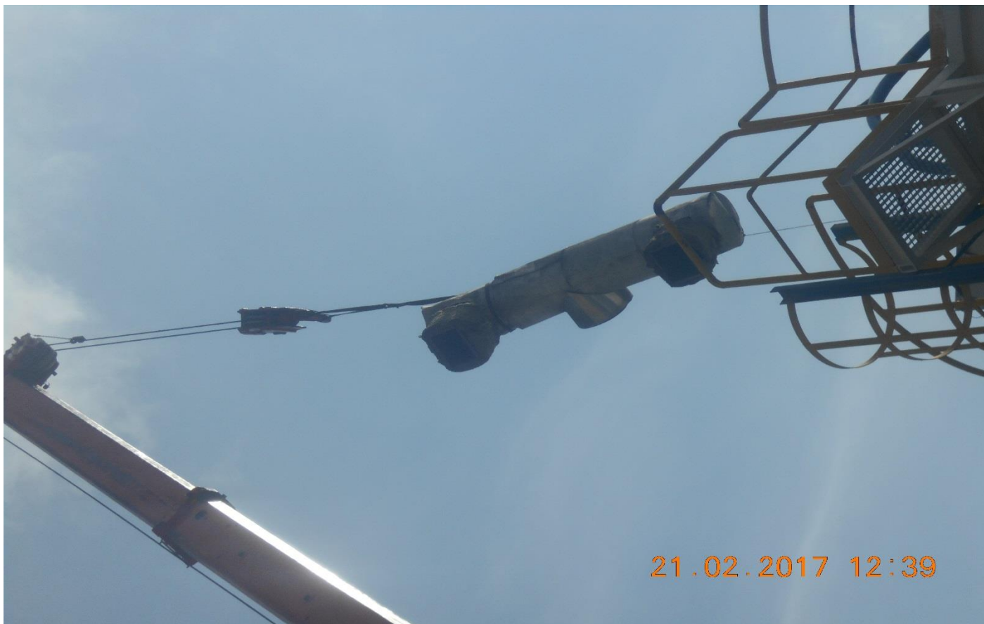
Φωτό 1094: Εργασίες συντήρησης
