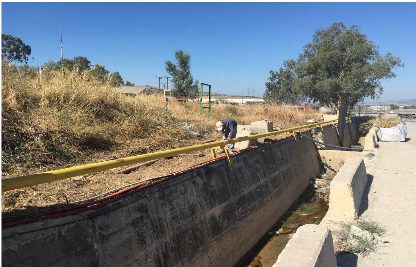
Φωτο 1476: Εργασίες βαψίματος σωληνώσεων φυσικού αερίου
