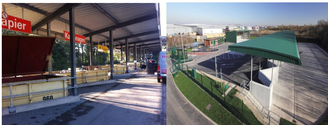
Εικόνα 14: Χώρος διαλογής μικρών ανακυκλώσιμων υλικών
