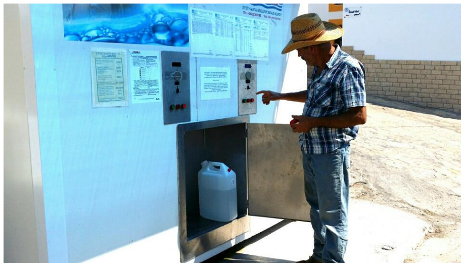
Φώτο 1: Αποψη waterkiosk
