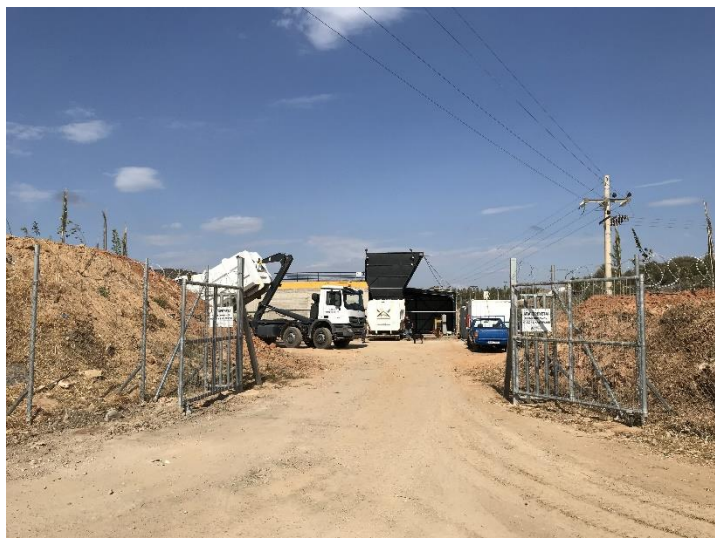
Εικόνα 16 Εγκατάσταση ΣΜΑ Δήμου Μαρκοπούλου Μεσογαίας
