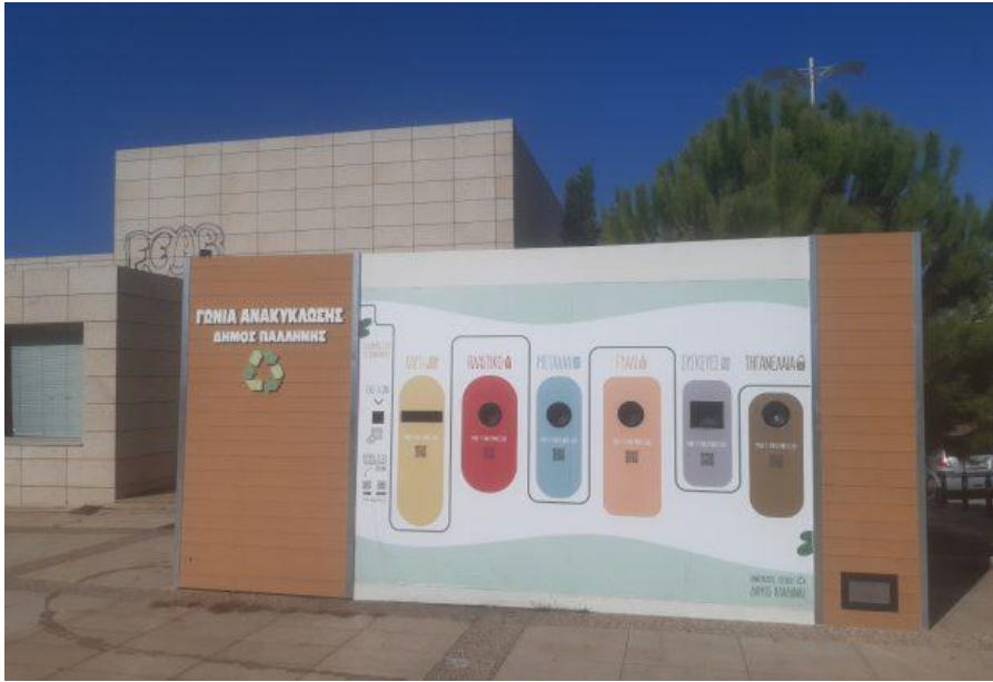
Εικόνα 5-5 : Ολοκληρωμένο Κέντρο Ανταποδοτικής Ανακύκλωσης στην Παλλήνη
