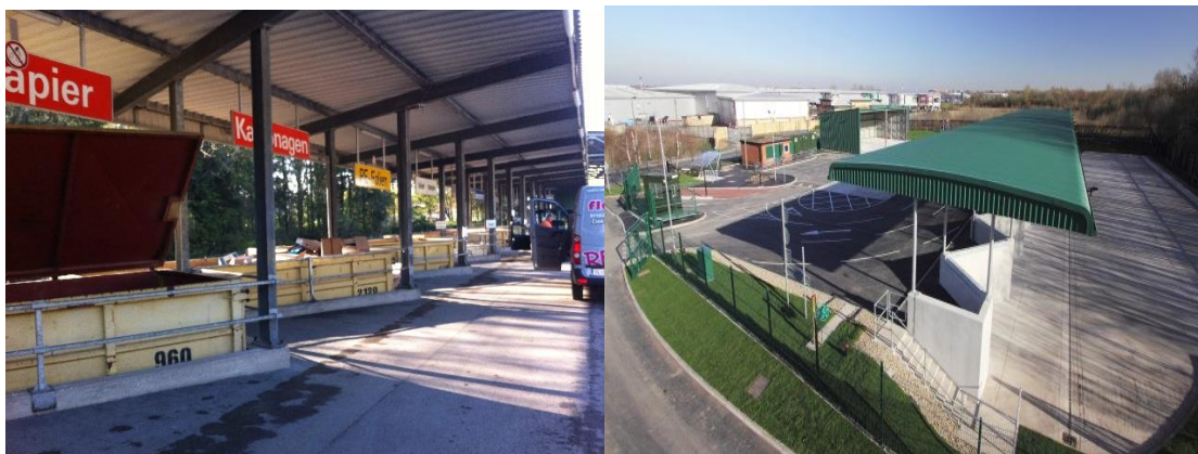
Εικόνα 13: Χώρος διαλογής μικρών ανακυκλώσιμων υλικών
