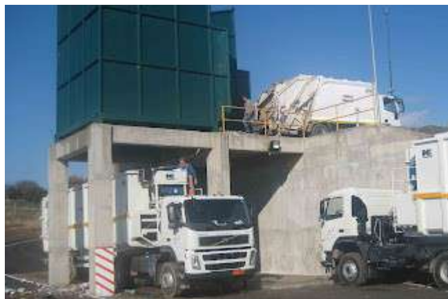
Εικόνα 17 Διάταξη Σταθμού Μεταφόρτωσης Απορριμμάτων
