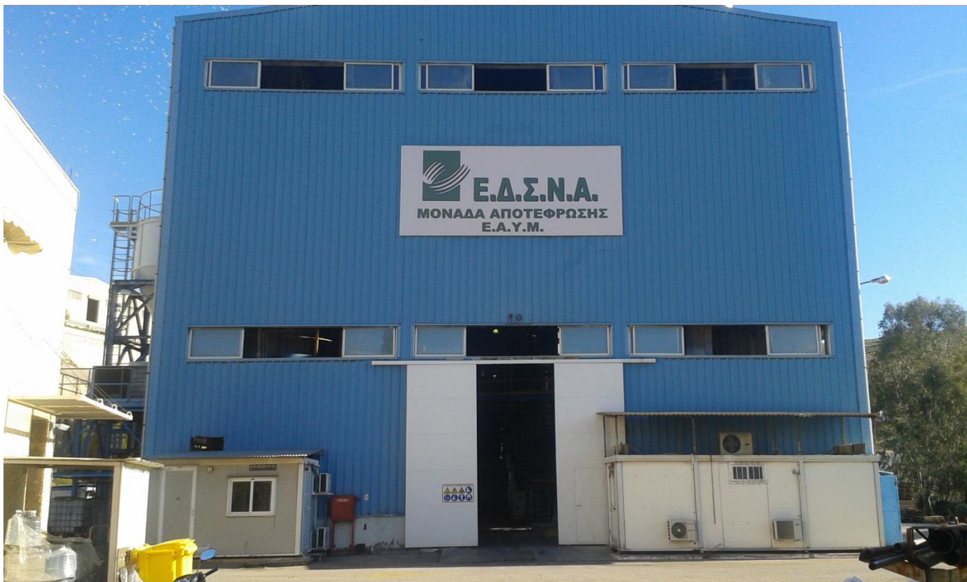
Φωτο 41: Τοποθέτηση νέας φωτιζόμενης πινακίδας
