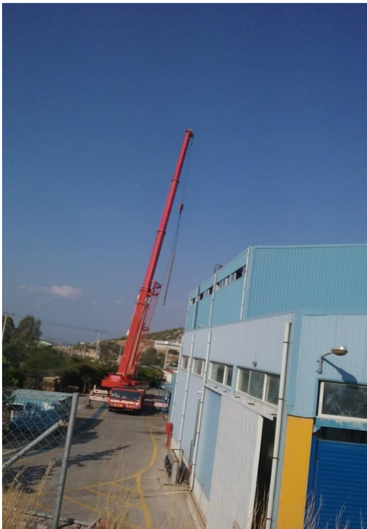
Φωτο 2: Γερανός για επισκευή συστημάτων Μονάδος
