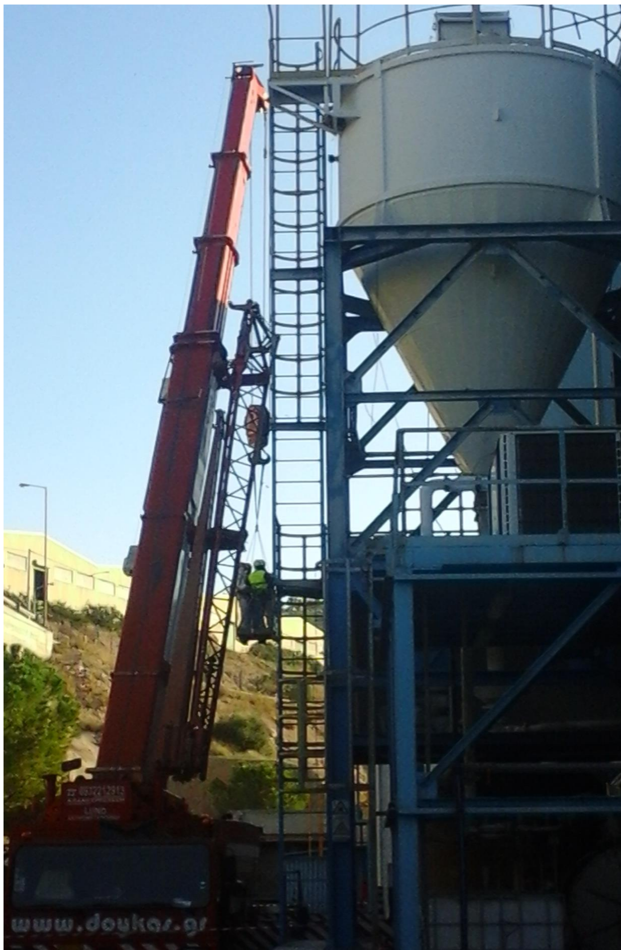
Φωτο 3: Γερανός για εργασίες συντήρησης και αναβάθμισης εξοπλισμού της γραμμής Β
