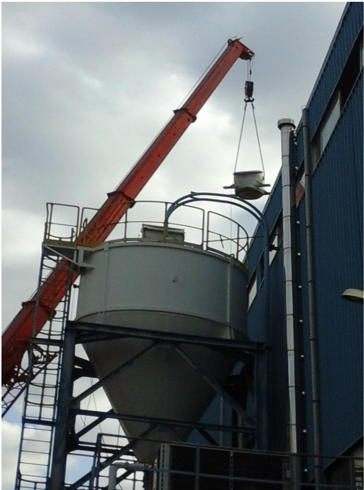
Φωτο1: Αποξήλωση καμπύλης εναλλάκτη Β γραμμής
