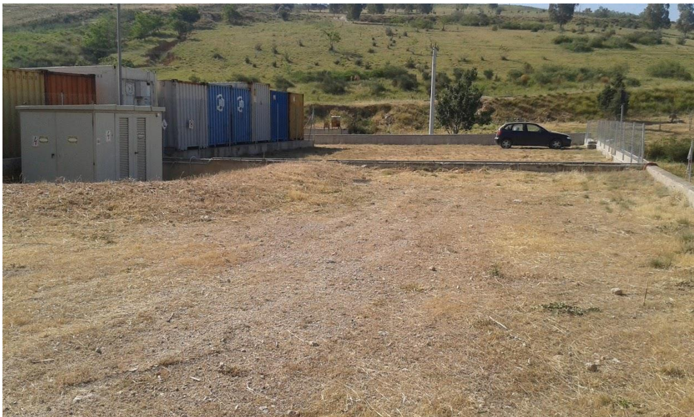
Φωτο 88: Καθαρισμός περιβάλλοντος χώρου προς χρήση ως parking των οχημάτων των εργαζομένων και επισκεπτών της εγκατάστασης
