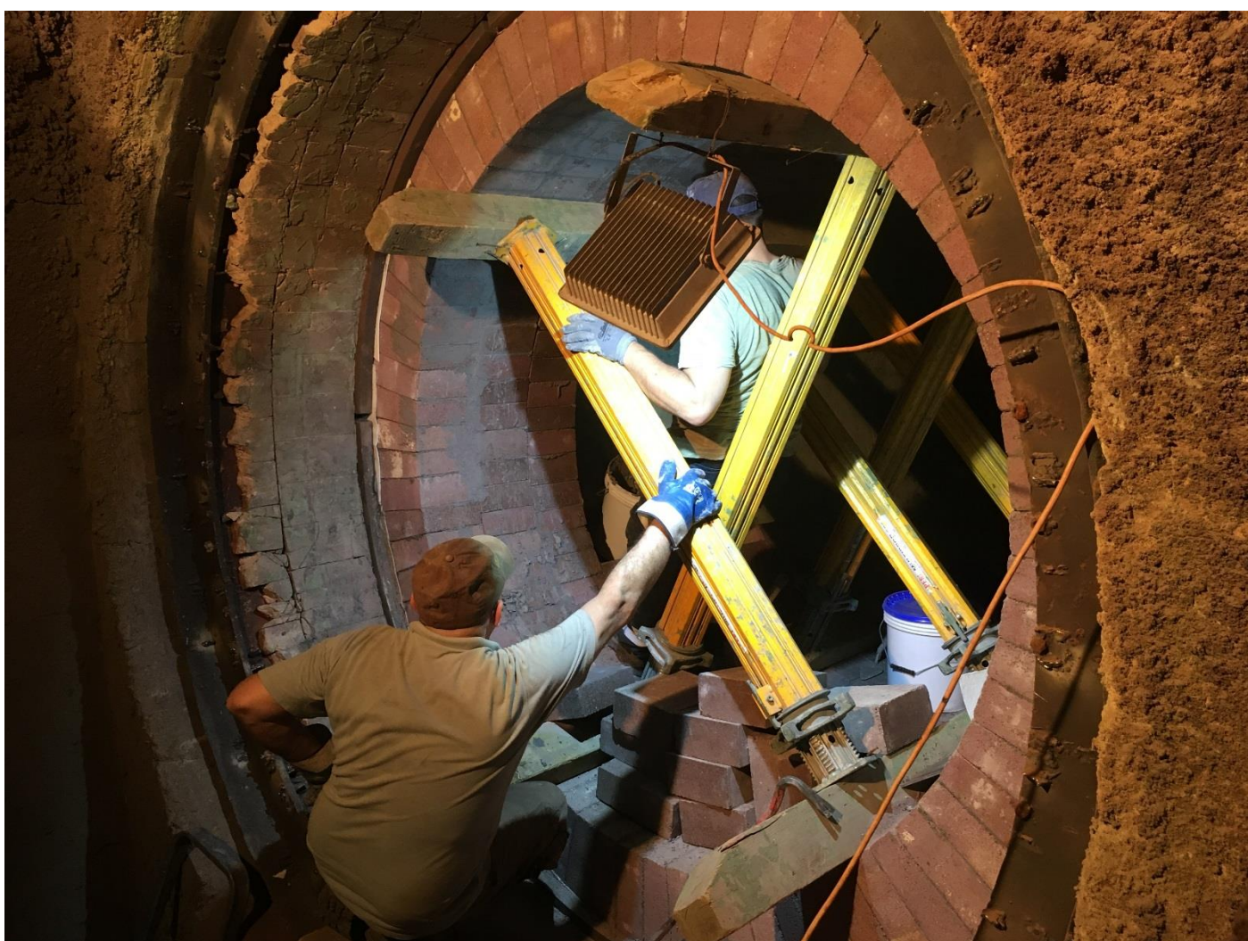
Φωτο 81: Τοποθέτηση νέας πυριμαχης επένδυσης εντός του κλιβάνου
