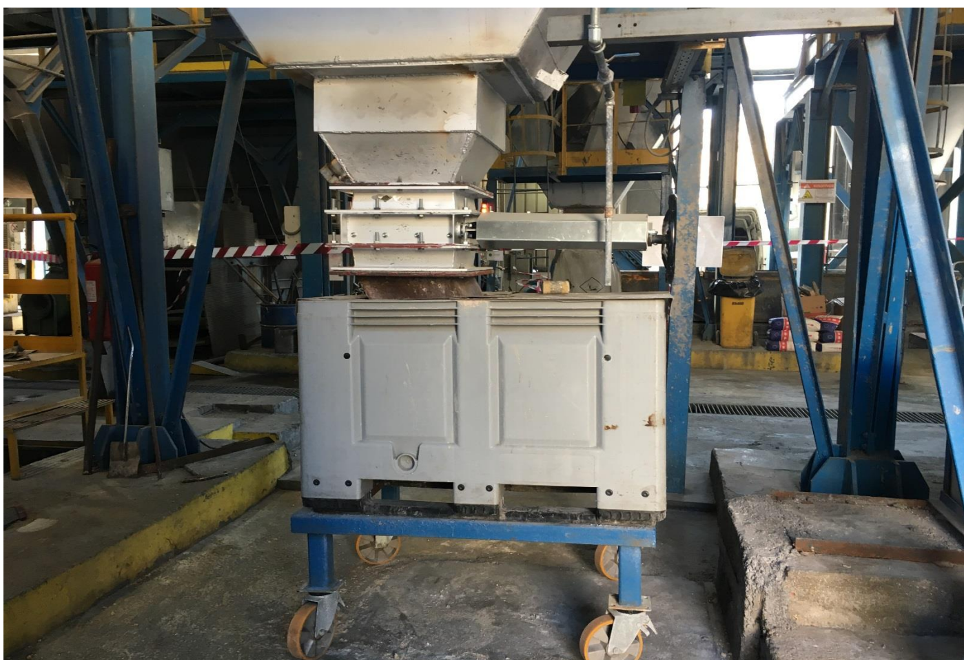
Φωτο 32: Νέα δεξαμενή λυματολάσπης στη μετάκαυση
