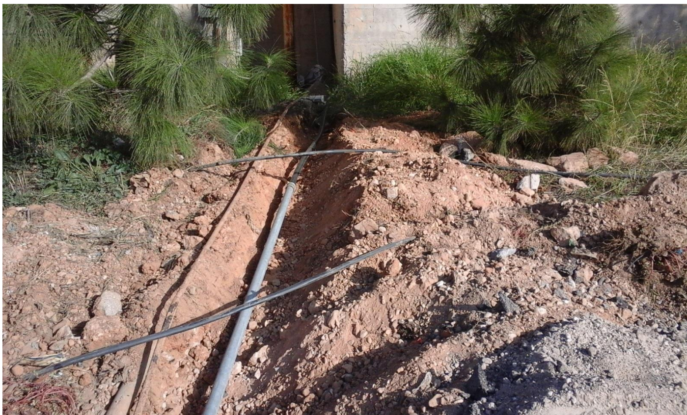
Φωτο 44: Αντικατάσταση καλωδίων ΟΤΕ
