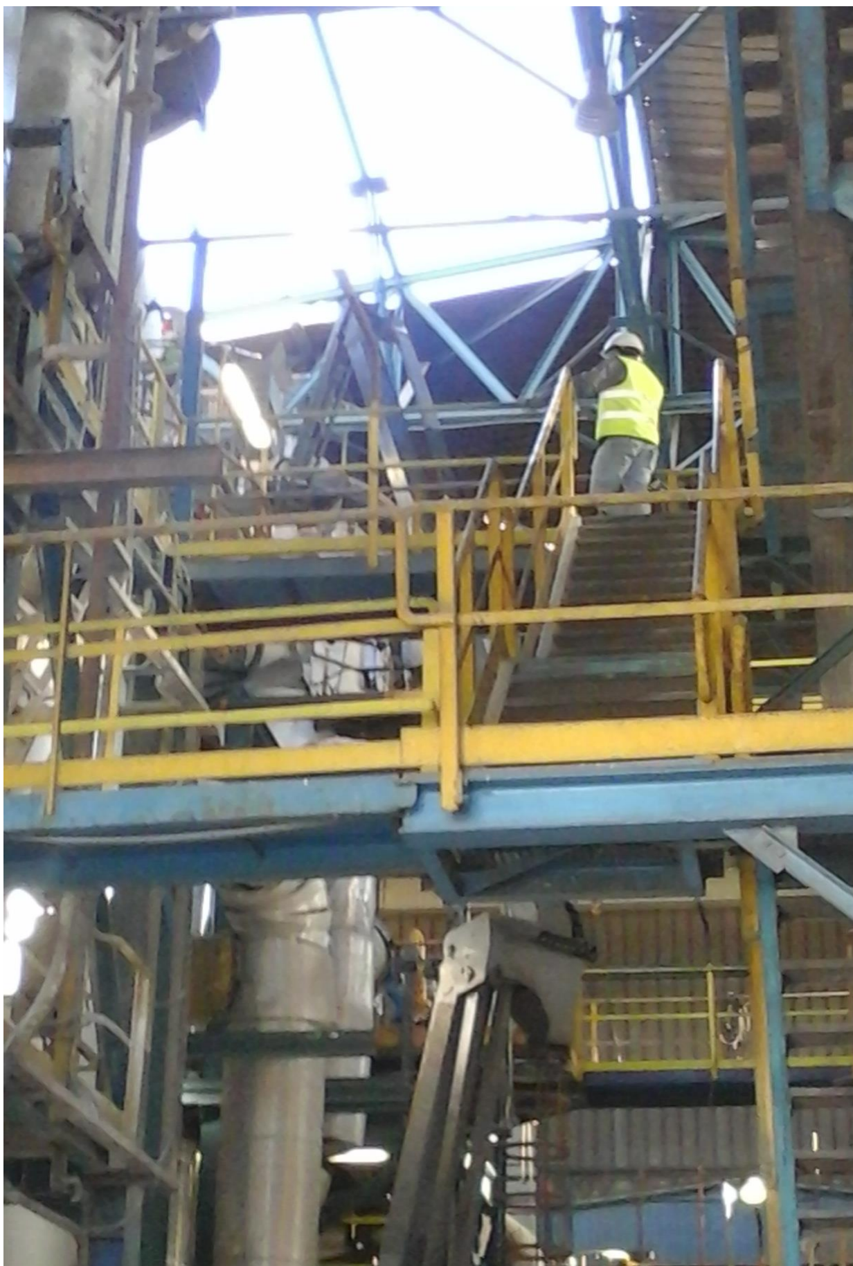
Φωτο 19: Εργασίες επισκευών στη Β γραμμή
