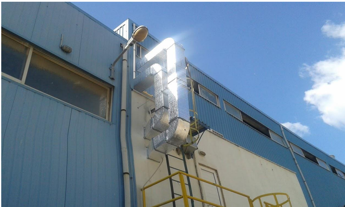
Φωτο 43: Αναβάθμιση εξαερισμού στο Control Room
