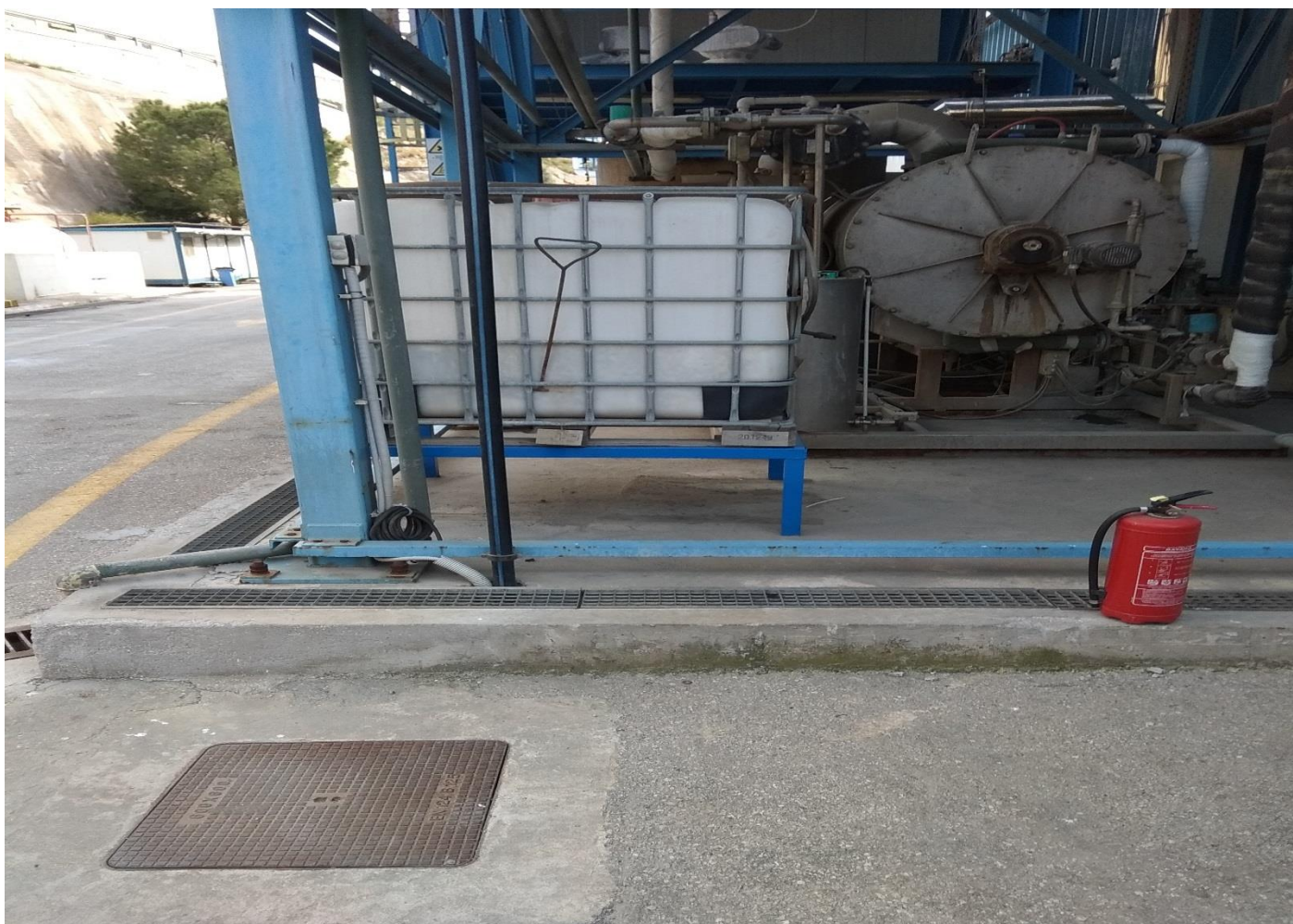
Φωτο 30: Νέα βάση δεξαμενής εξατμιστή
