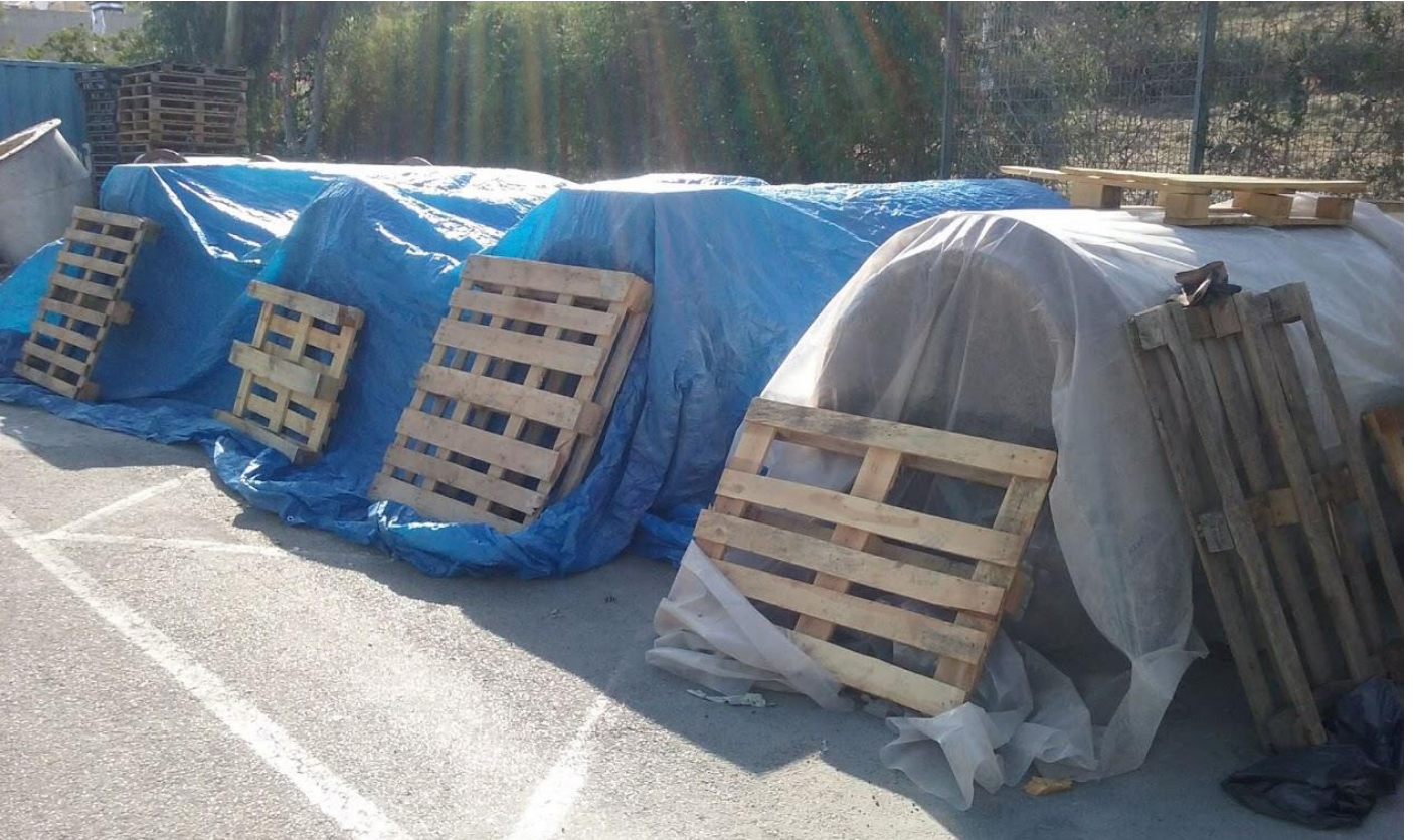
Φωτο 5: Εξοπλισμός εναλλάκτη Α εν αναμονή για μεταφορά εκτός μονάδος για συντήρηση
