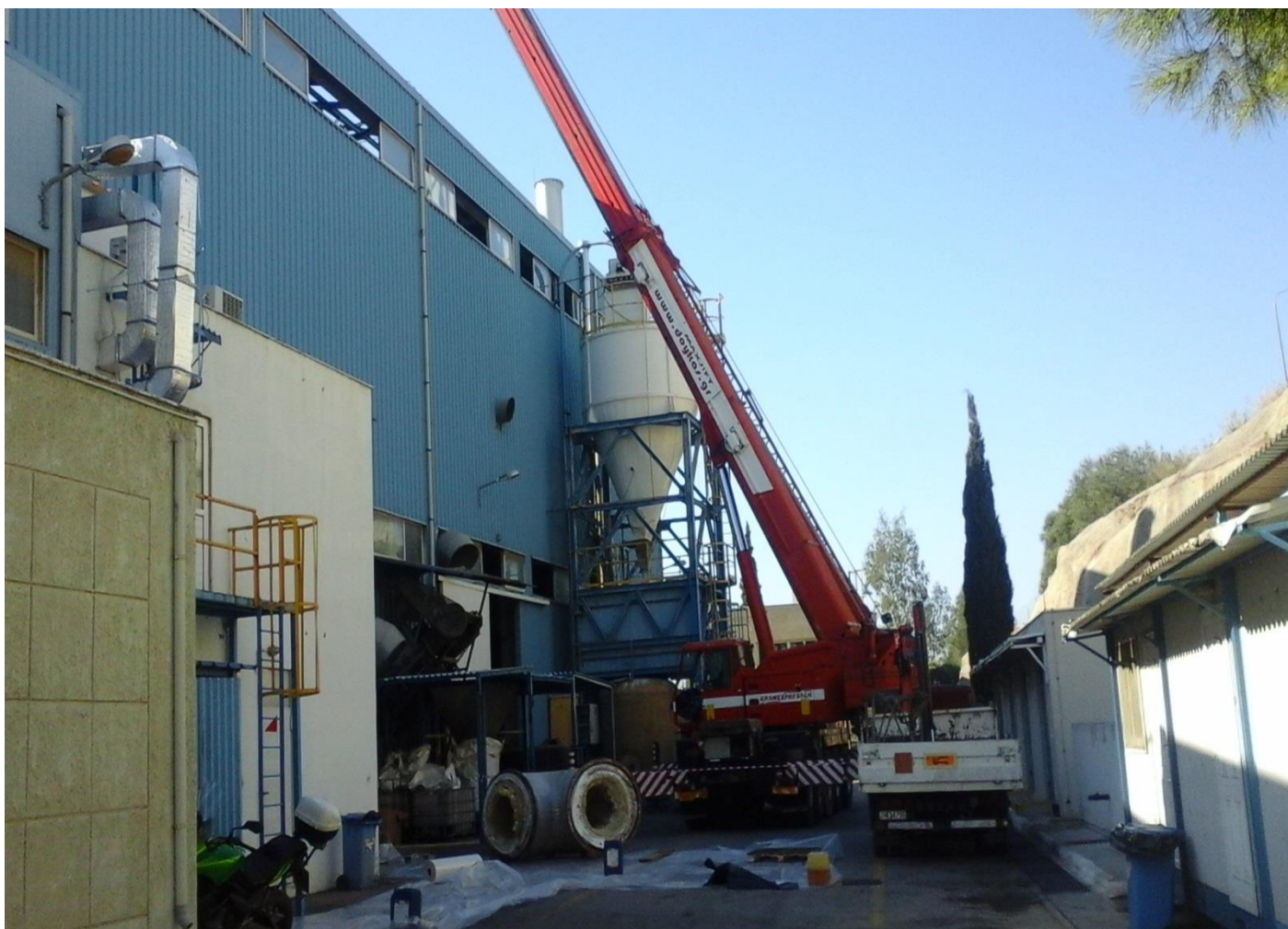
Φωτο 18: Εργασίες επισκευών στη Β γραμμή
