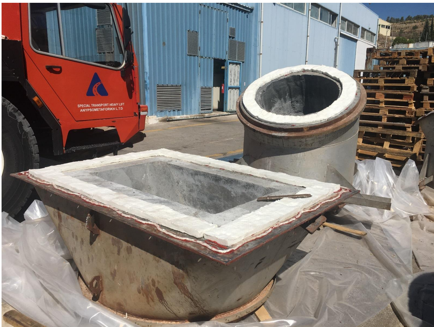
Φωτο 39: Αντικατάσταση πυρίμαχης επένδυσης ενδιάμεσων αγωγών
