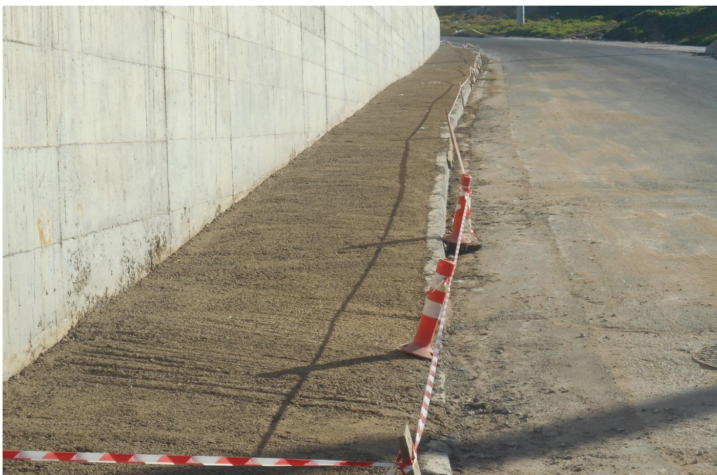
Φωτο 89: Κατασκευή εξωτερικού πεζοδρομίου πλησίον της πλατφόρμας αποθήκευσης τεφρών. Πεζή όδευση εργαζομένων Μονάδος στο χώρο parking
