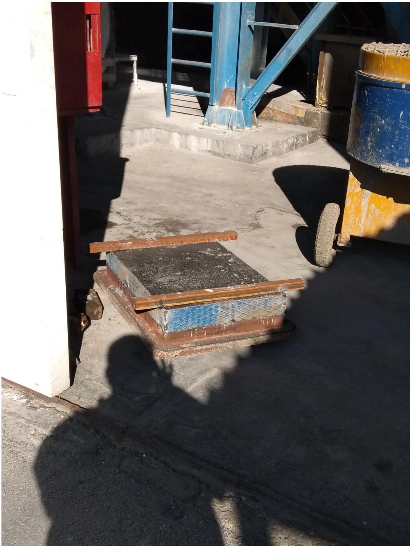
Φωτο 24: Κατασκευή καλουπιού μπετόν για δάπεδο θαλάμου καύσης και μετάκαυσης
