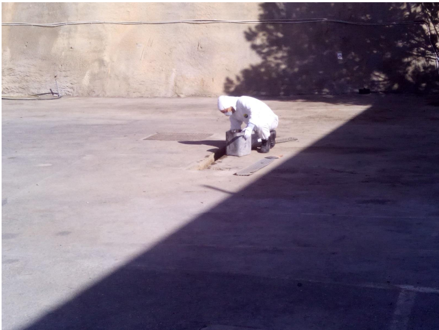
Φωτο 23: Καθαρισμός φρεατίων της Μονάδος εντός του οικοπέδου
