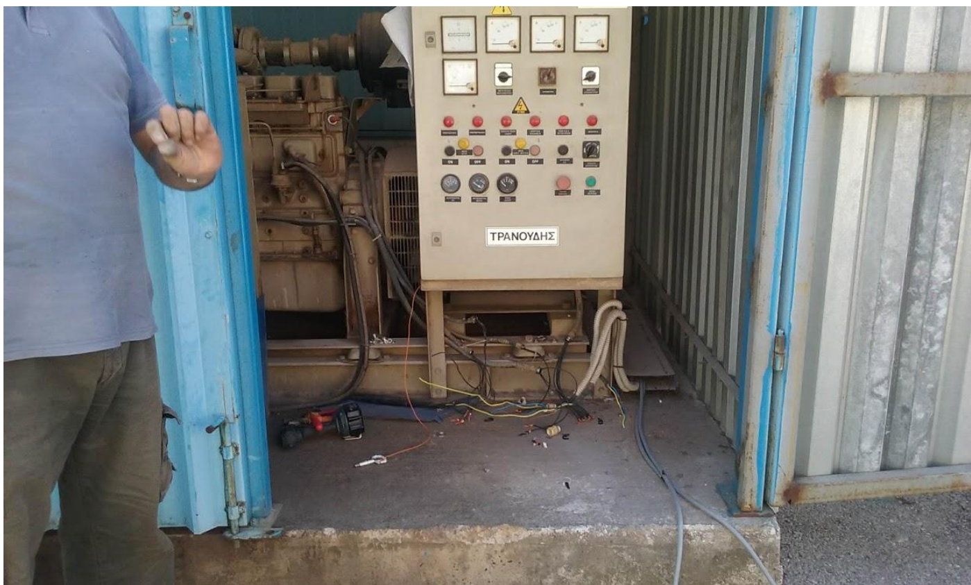
Φωτο 60: Τοποθέτηση νέου ηλεκτρολογικού πίνακα για Η/Ζ
