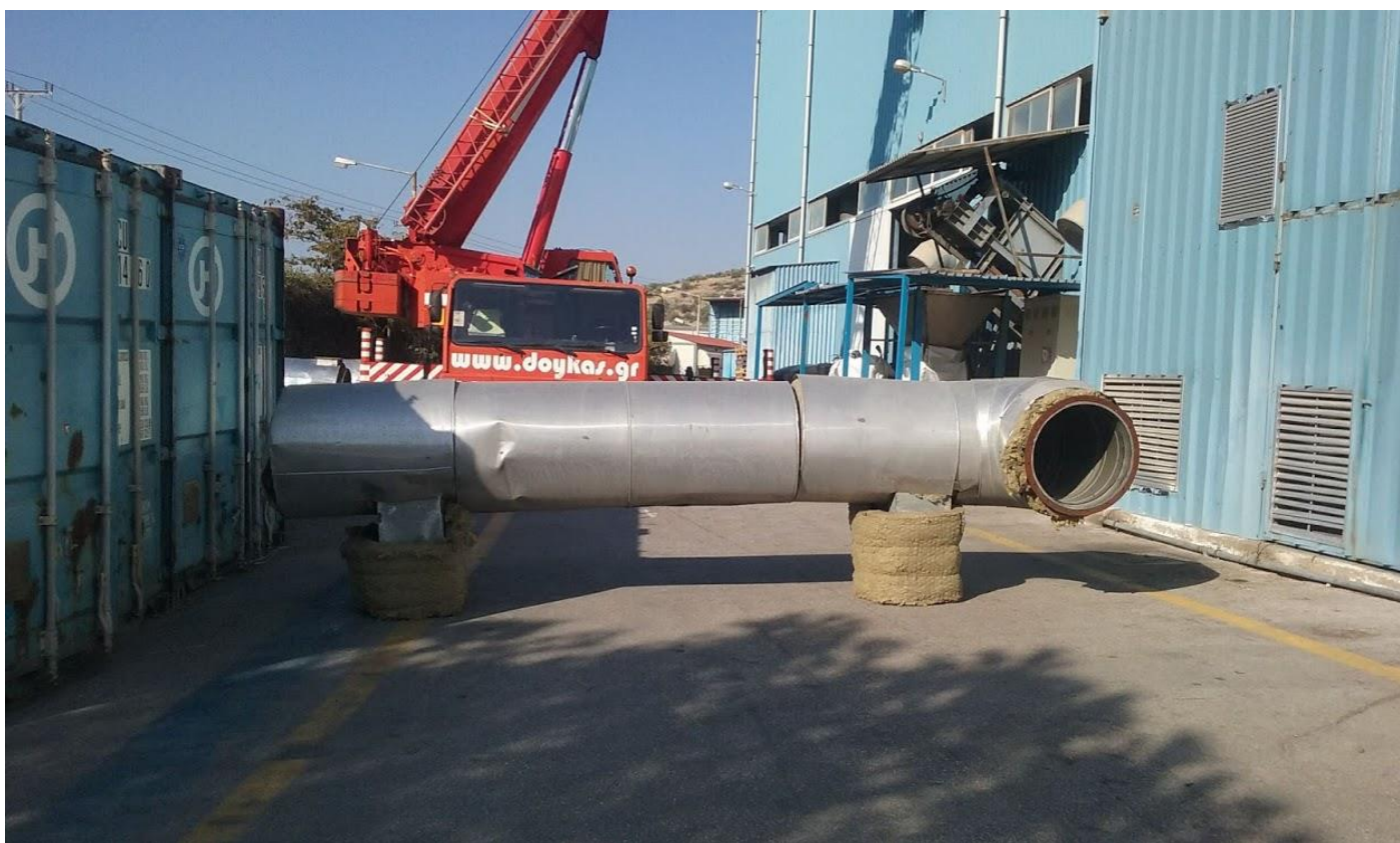
Φωτο 14: Εργασίες αντικατάστασης αεραγωγού εναλλάκτη θερμότητας
