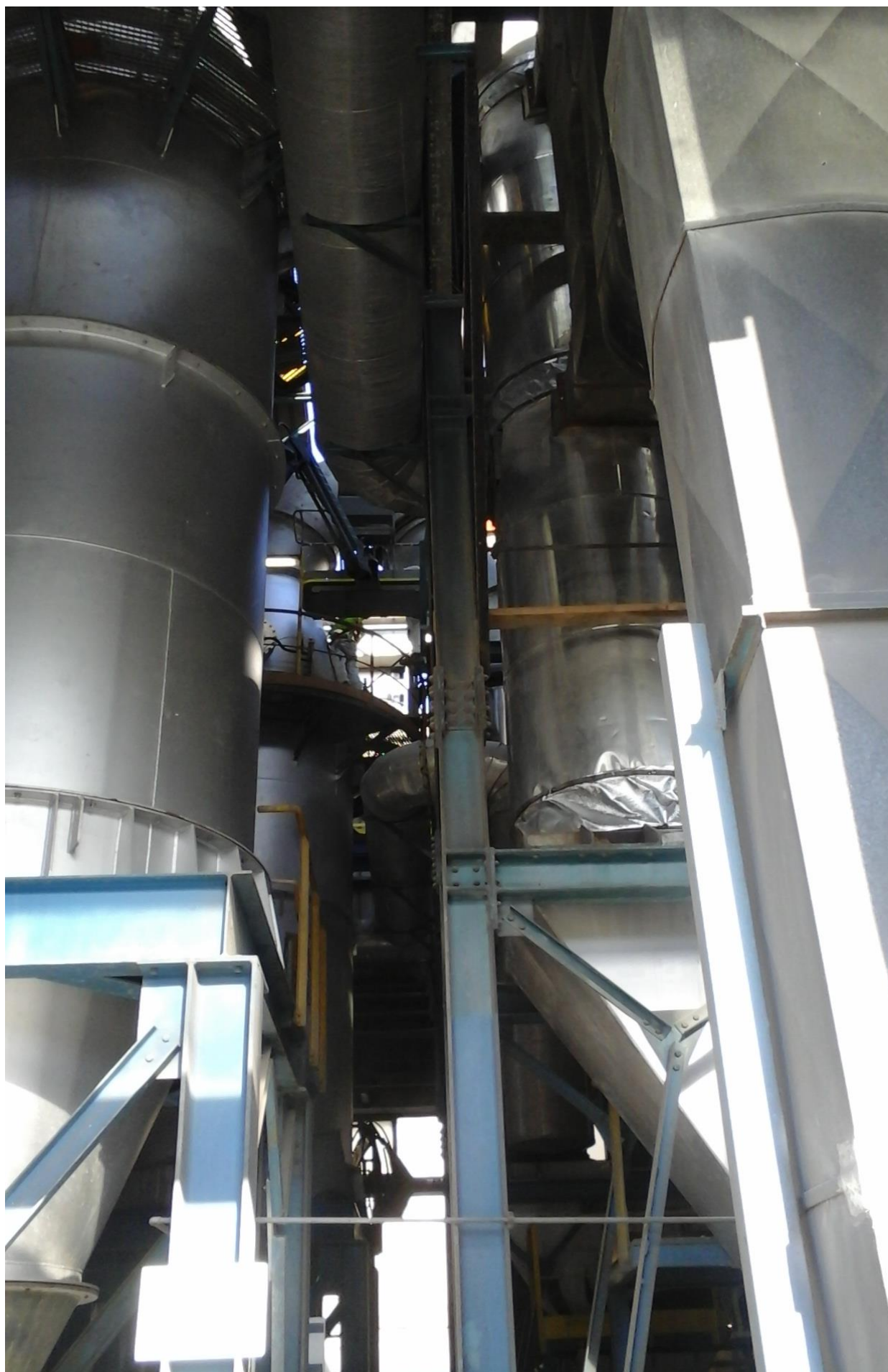
Φωτο 50: Επανατοποθετημένα μετά από εκτεταμένη συντήρηση στοιχεία εναλλάκτη θερμότητας
