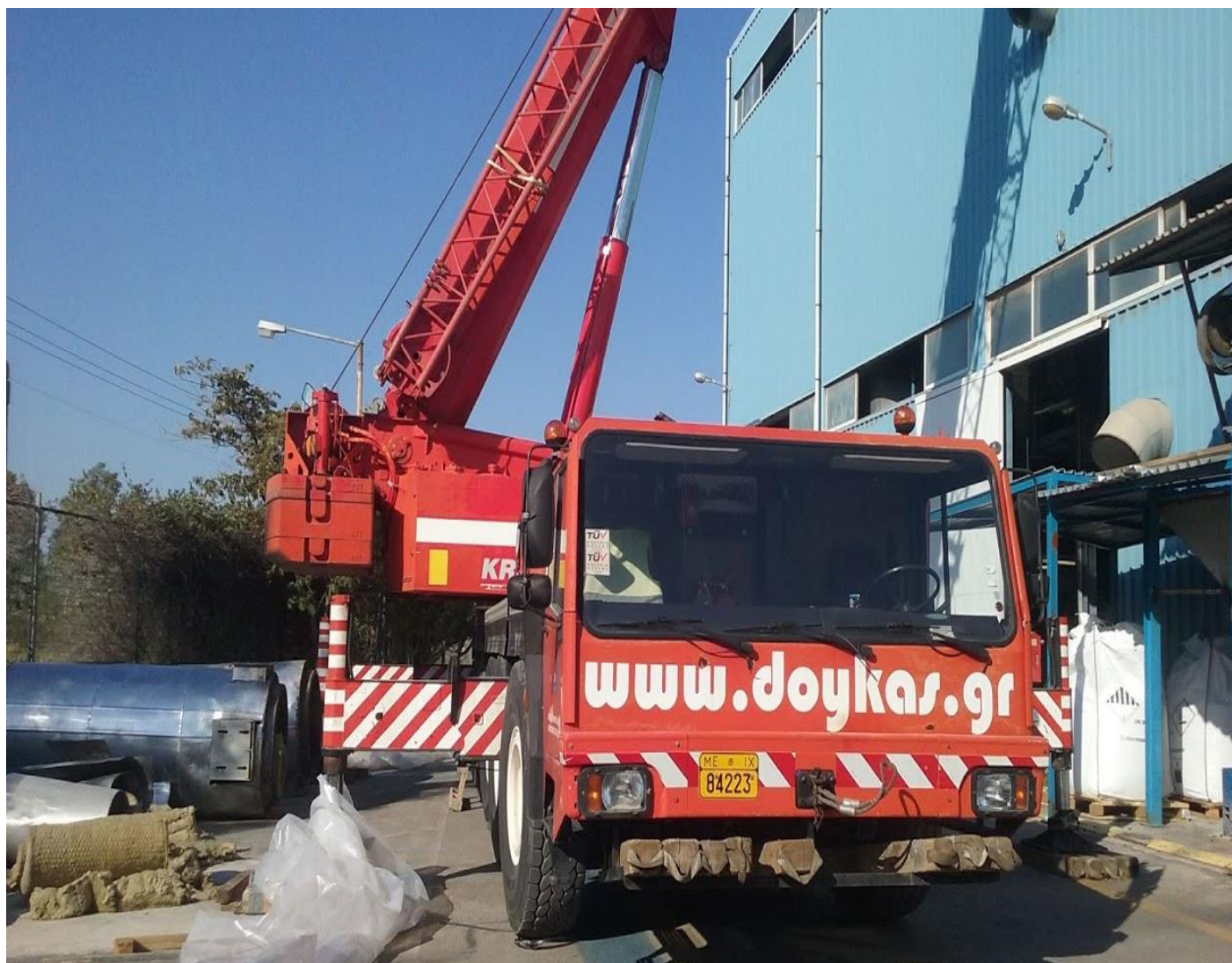
Φωτό 15: Εκτεταμένες εργασίες αντικατάστασης εναλλακτών θερμότητας
