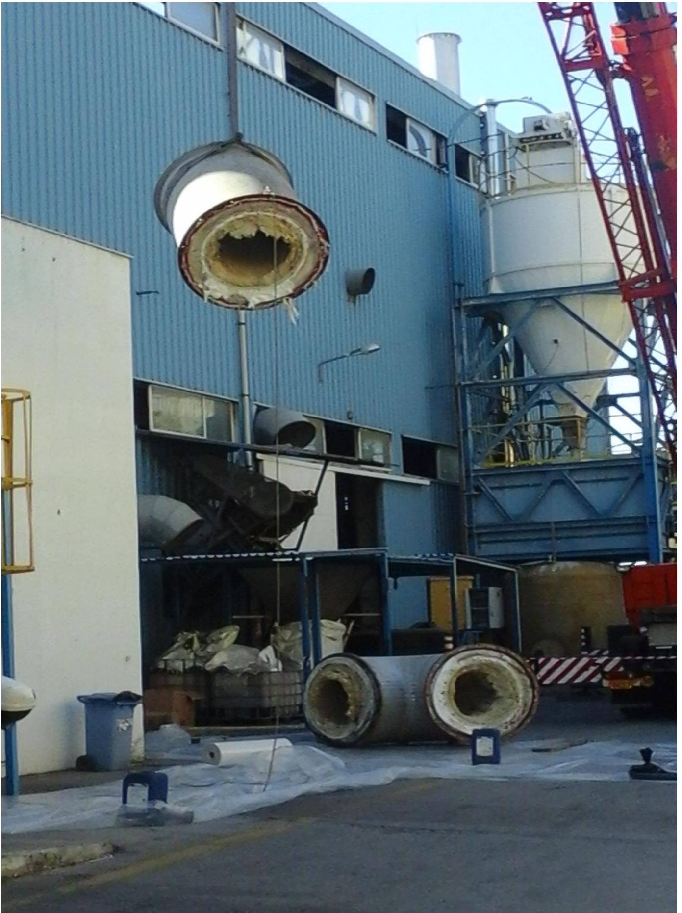
Φωτο 17: Εργασίες επισκευών στη Β γραμμή
