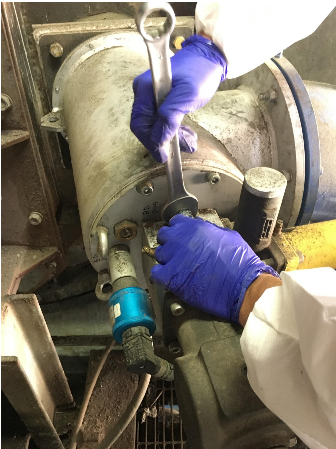
Φωτο 55: Συντήρηση νέου καυστήρα κλιβάνου καύσης
