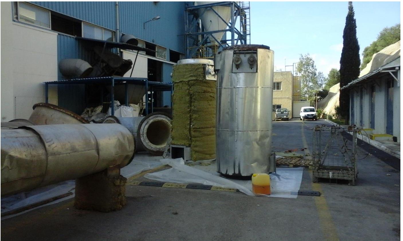
Φωτό 49: Αεραγωγοί – καμπύλες εναλλάκτη και τοποθέτηση νέας μόνωσης
