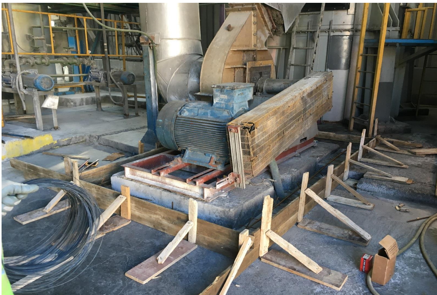
Φωτο 25: Κατασκευή βάσης για τοποθέτηση νέου ηχομονωτικού θαλάμου
