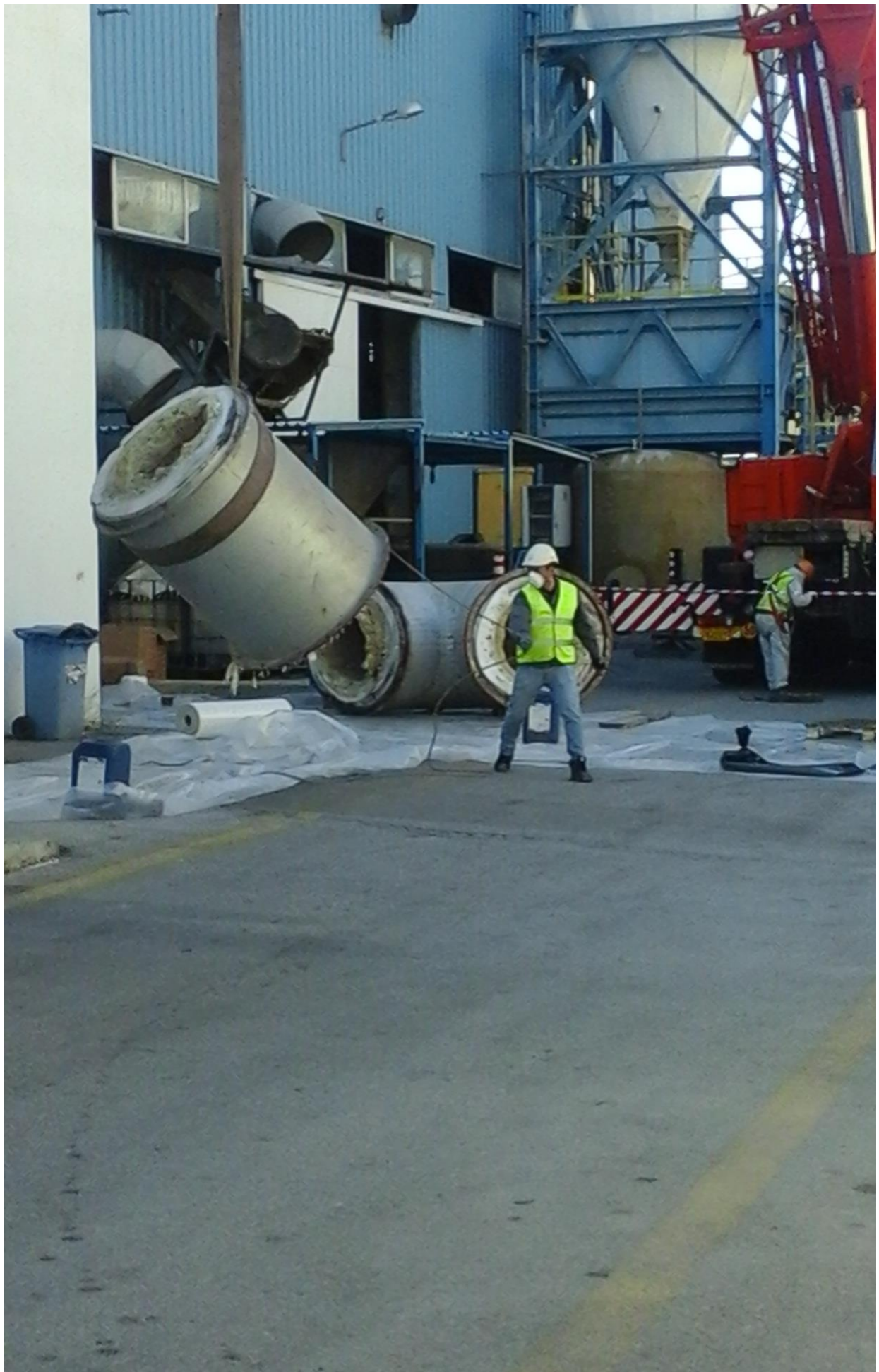
Φωτο 12: Επίσκεψη εξοπλισμού Μονάδος
