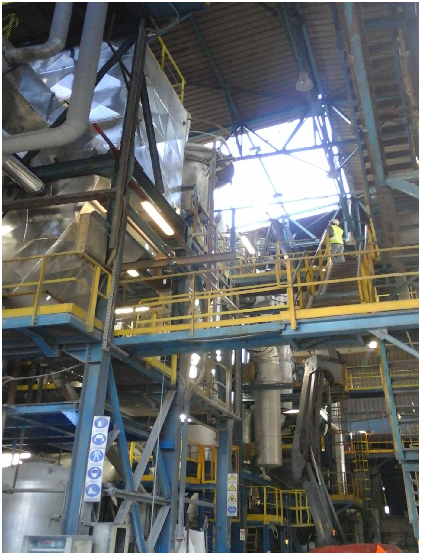
Φωτο 16: Εργασίες στη Β γραμμή μέσω αφαίρεσης στοιχείων οροφής
