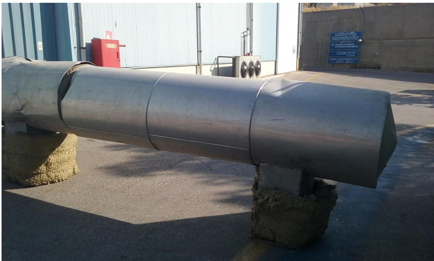
Φωτο 13: Εργασίες αντικατάστασης αεραγωγού εναλλάκτη θερμότητας
