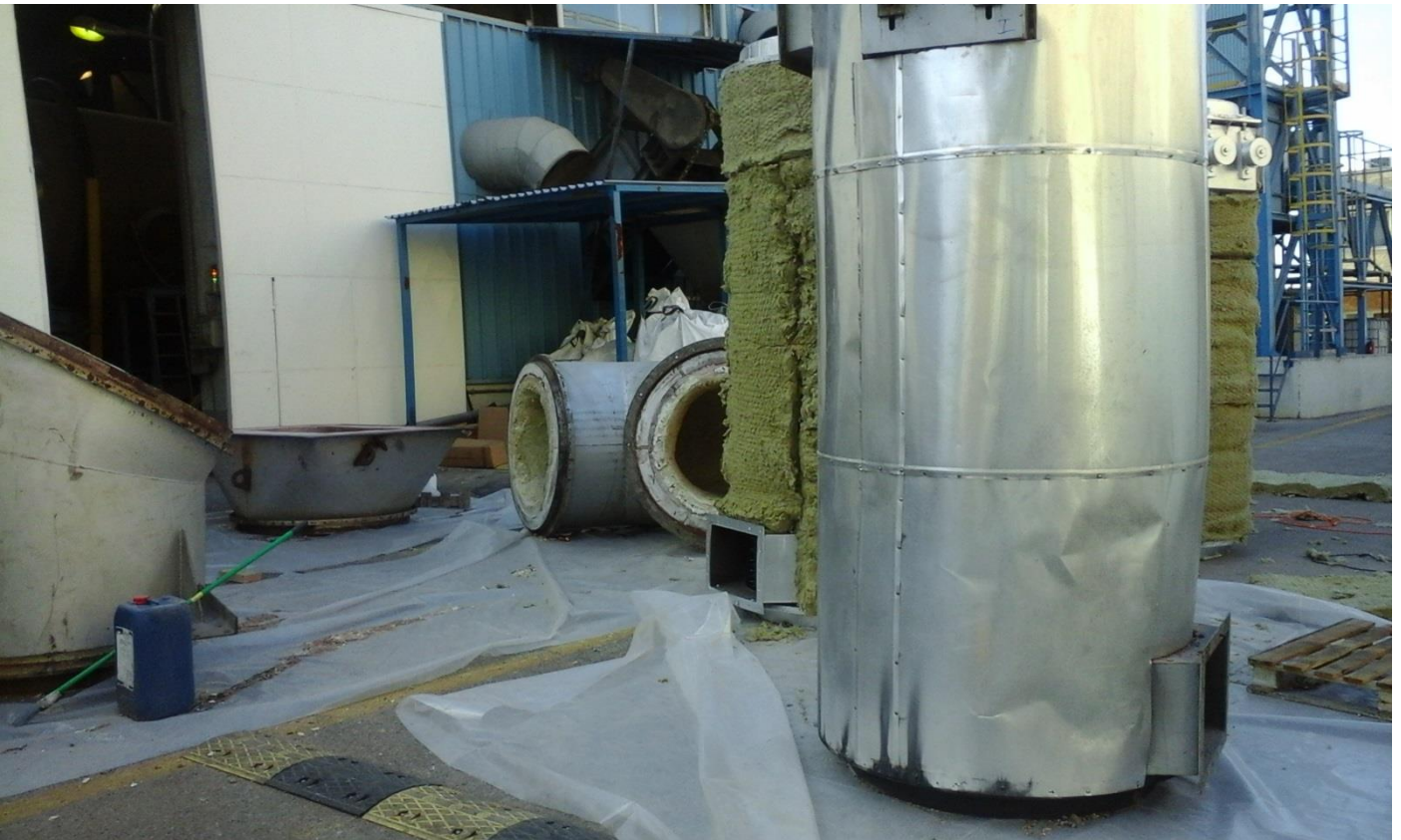
Φωτό 4: Εναλλάκτης – Καμπύλες – Τετράγωνος κώνος Μετάκαυσης γραμμής Β'
