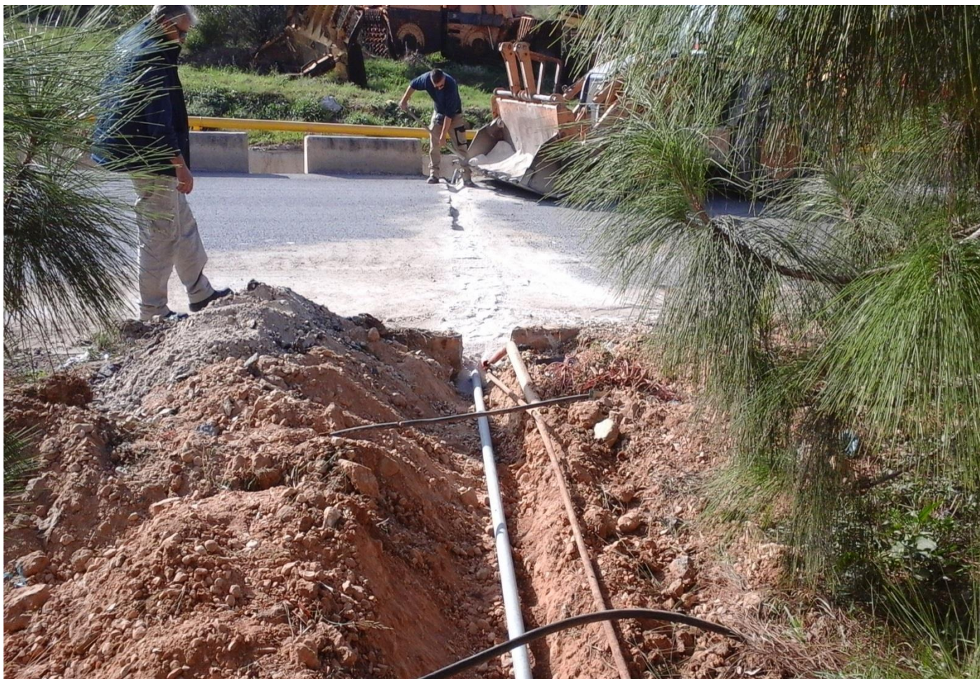
Φωτο 20: Εργασίες νέας καλωδίωσης ΟΤΕ
