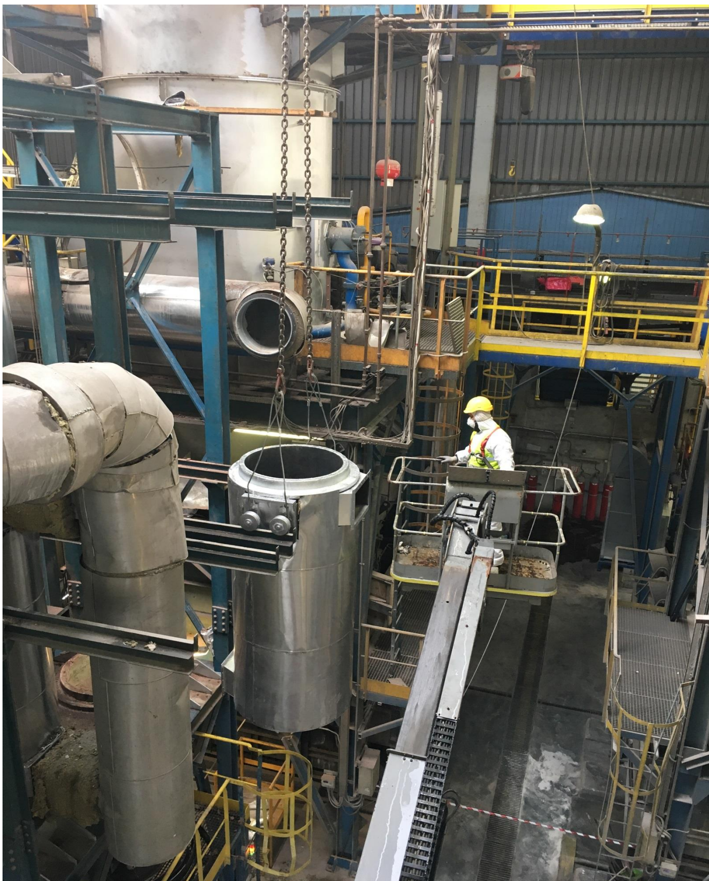
Φωτο 21: Αντικατάσταση εναλλακτών θερμότητας
