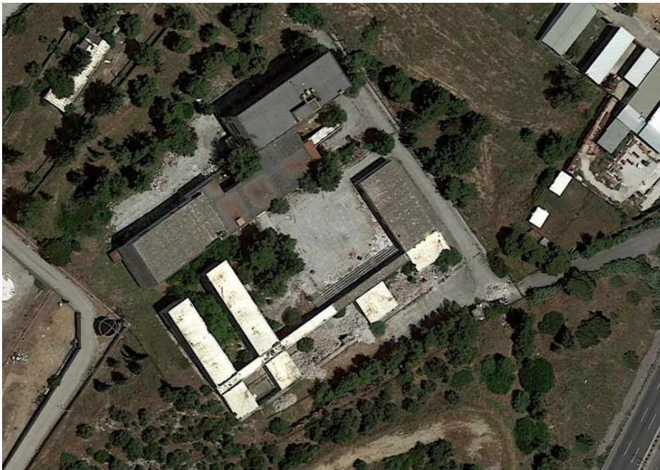
Εικόνα 8-9: Άποψη του διατιθέμενου χώρου στη θέση πρώην ΟΑΕΔ (Google Earth)
