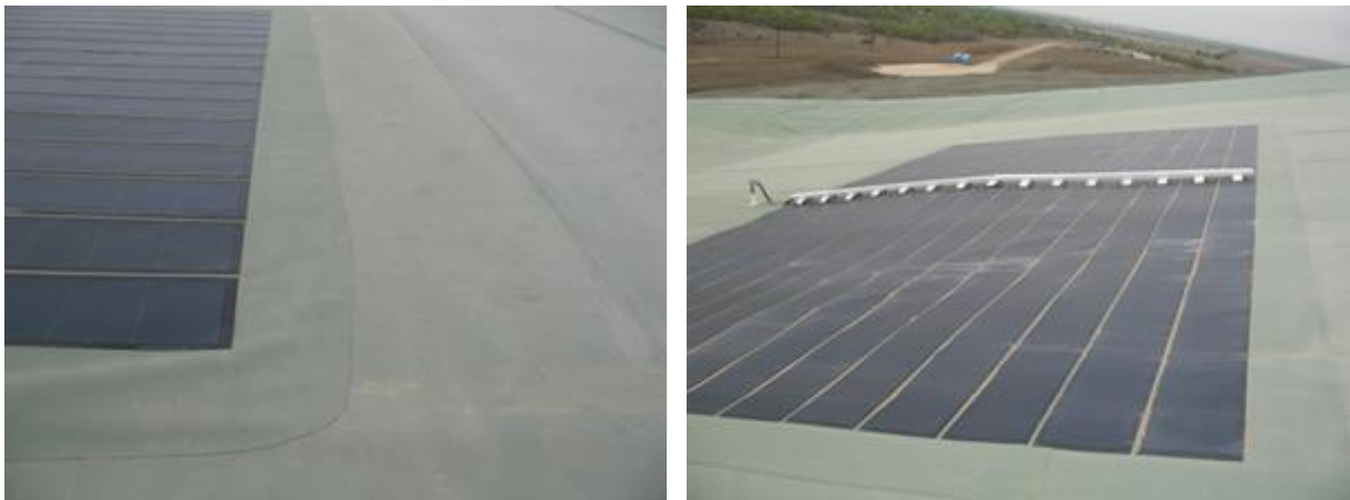
Εικόνα 15: Ενδεικτική απεικόνιση συστήματος στήριξης επί γεωσυνθετικής επιφάνειας
